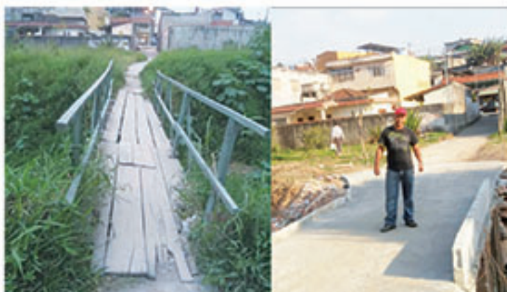
O antes e depois da ponte, que foi reformada após reivindicações do grupo Patrulha dos Bairros
