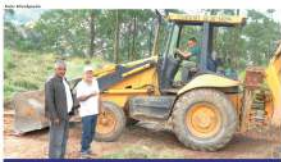
Severino do MSTU visitou as obras do novo empreendimento em Mauá
