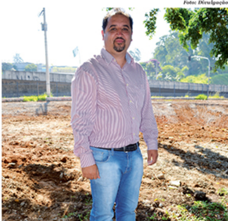
O presidente da Câmara Municipal, Marcelo Oliveira, acompanha início das obras no Parque da Juventude
