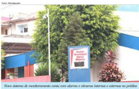
Novo sistema de monitoramento conta com alarme e câmeras internas e externas nos prédios
