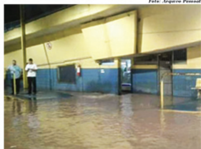
Toda região onde está localizado o Terminal de Ônibus Central ficou alagada
