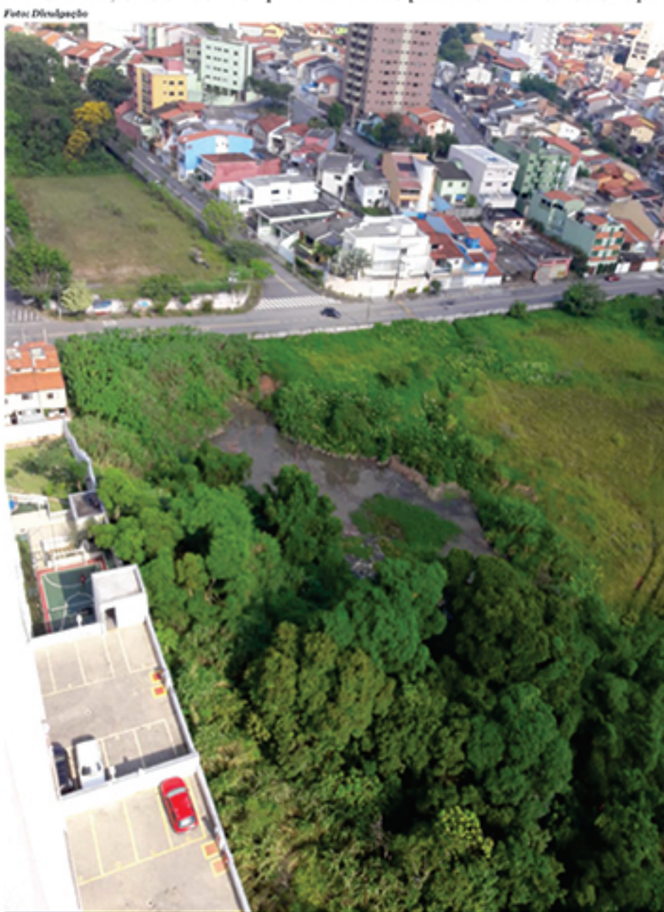
Foto tirada de um dos prédios mostra situação do esgoto no terreno
