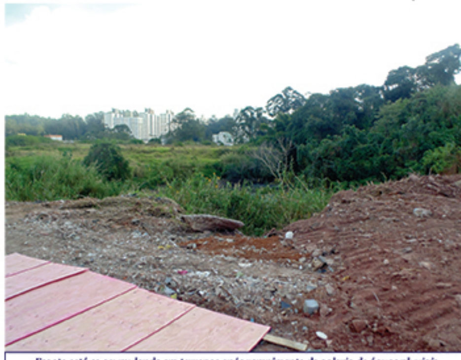
Esgoto está se acumulando em terrenos após rompimento de galeria de águas pluviais
