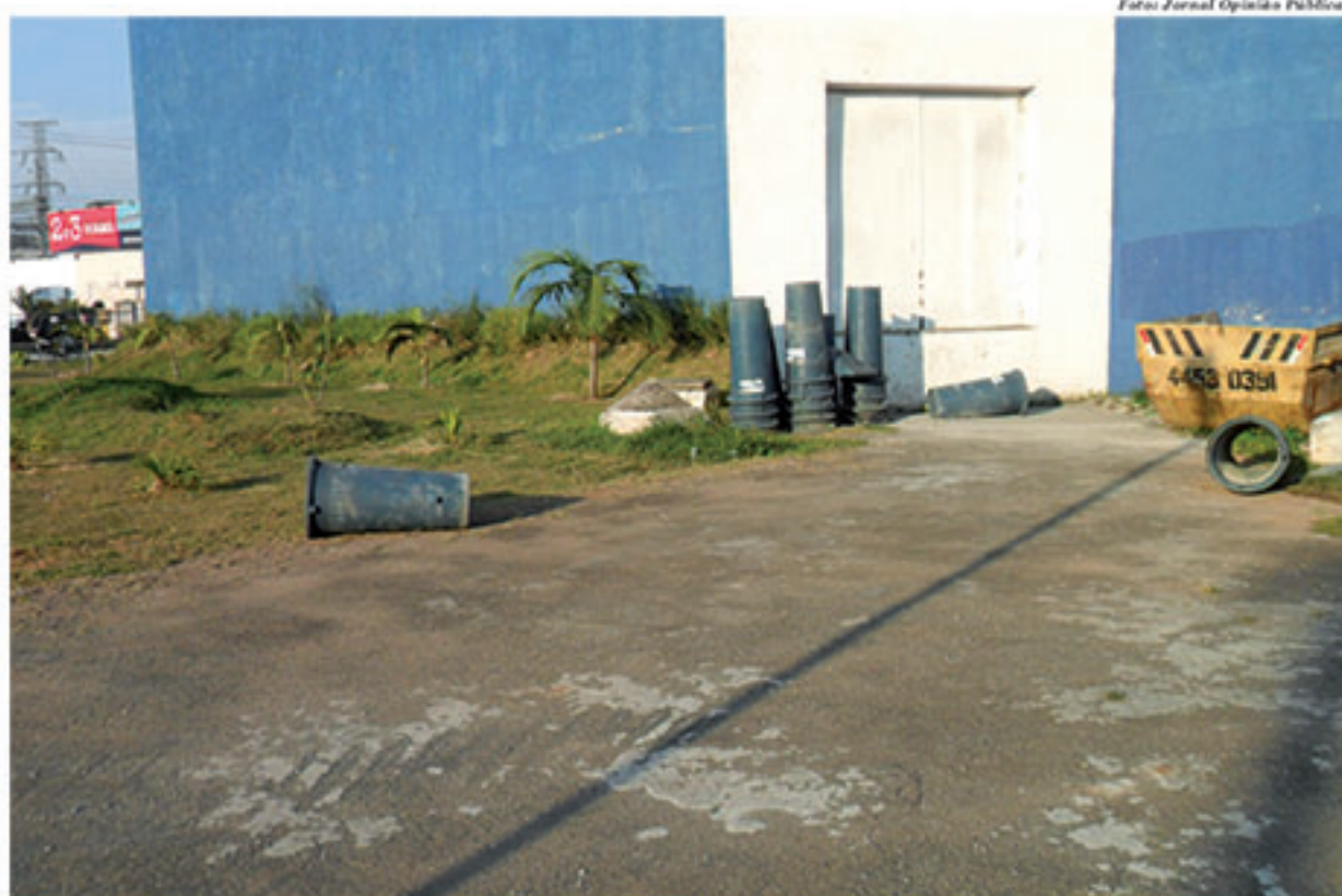
Meliantes utilizam a parte dos fundos do Teatro Municipal de Mauá para invadi-lo ou como rota de fuga
