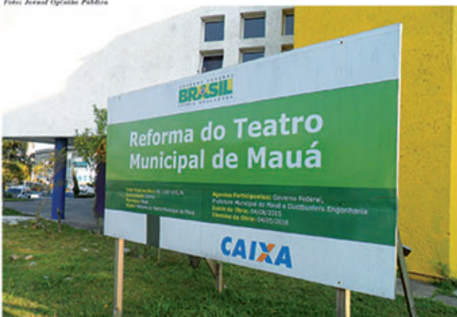
Placa indica que reforma do Teatro deveria ter sido entregue em maio. Entretanto, o espaço segue fechado e sem a segurança necessária
