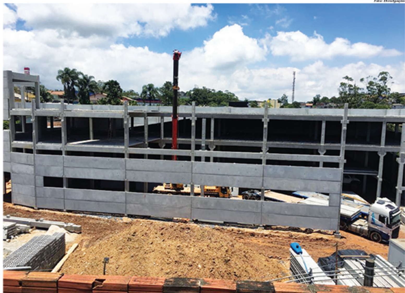
Obras do supermercado Lourencini em Rio Grande da Serra usam estruturas pré-moldadas, que facilitam a construção do prédio que abrigará a loja
