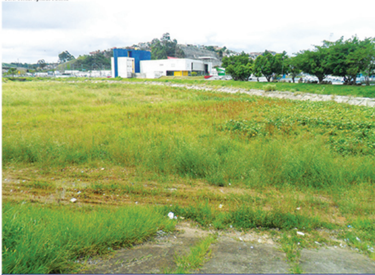
No fim de 2016, piscinão estava em situação precária. Vários alagamentos foram registrados na região ao longo dos últimos anos
