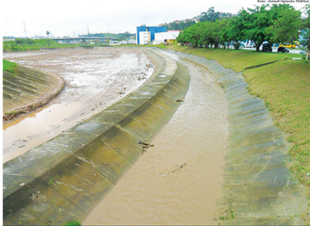
Atual estado do piscinão do Paço Municipal. Limpeza ajudou a evitar alagamentos na região apesar das chuvas
