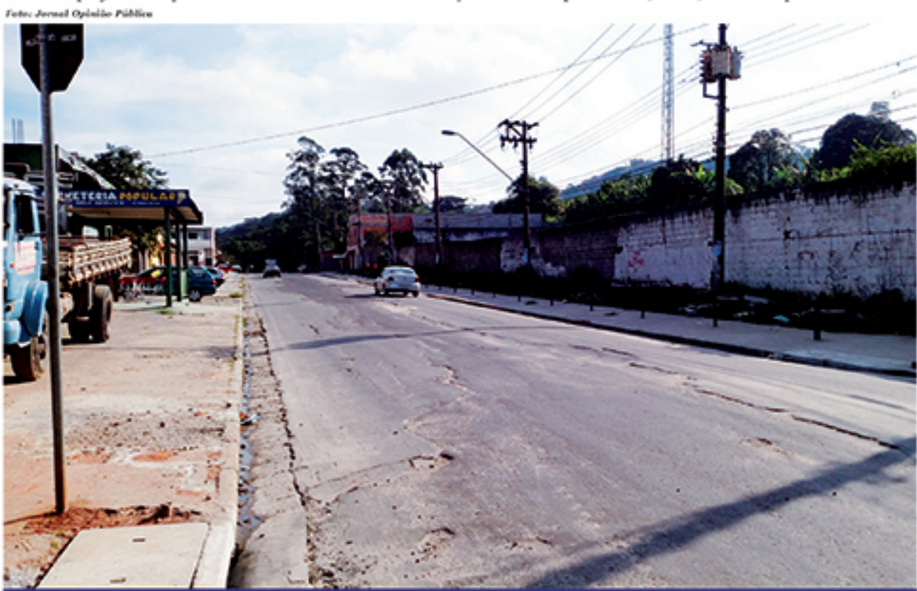
Apesar do trânsito na Avenida Kuwahara já estar fluindo normalmente, Prefeitura de Mauá alega que obra da SABESP "não foi concluída"
